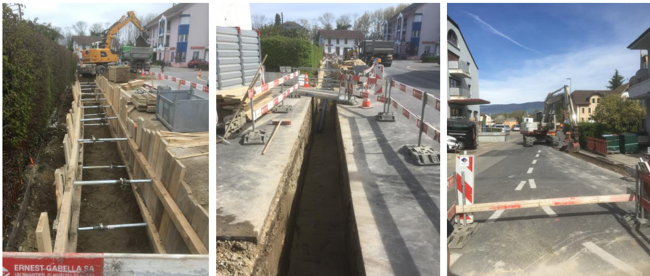
A gauche et au centre : fouille sous le futur trottoir pour la conduite d'eau potable ; à droite : travaux préparatoires sur le carrefour avec la rue de la Tannerie.
