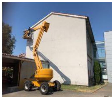
Réfection des virevents du collège
