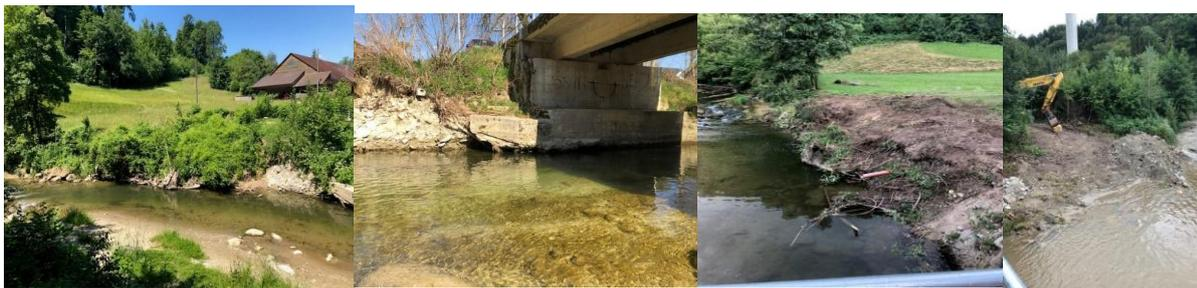
Depuis plusieurs années la Menthue, forte de crues importantes, s'appuie sur la rive coté village en amont du pont du casino, sur la rive opposée des dépôts de sable se sont accumulés. Tant et si bien que la pile du pont a été touchée par cette érosion qui a creusé ses appuis dans le lit de la rivière.
