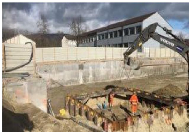
Une fois la fosse dégagée, les travaux de mise en forme du radier, la construction des murs grandes hauteurs, le drainage du terrain, la pose des canalisations et tuyaux pour les services, ont occupé l'entier de l'année 2020. À la fin de
