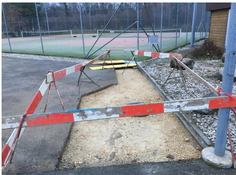
*A gauche, une tranchée d'infiltration le long des courts 2 et 3 ; à droite localisation de la chambre avec dépotoir qui permet d'absorber les surplus d'eau en cas de forte pluie.*
