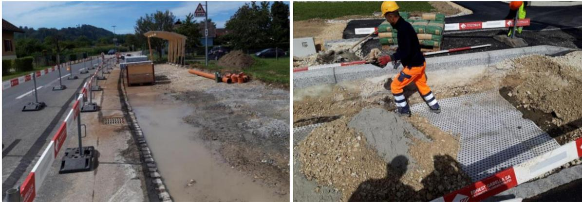
A gauche, les travaux de démontage ; à droite les travaux de stabilisation du terrain à l'aide d'une natte et de ciment.
