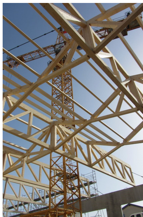
Charpente en bois
