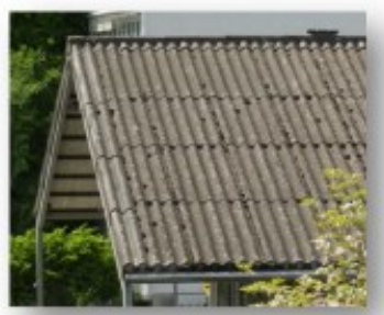
Bacs à fleurs, plaques, dalles, tuiles ondulées datant d'avant 1991
