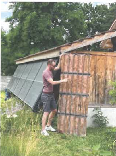
M. Raselli explique le principe d'un panneau solaire thermique, à côté de l'installation (à la pêcheirie d'Yvonand)
