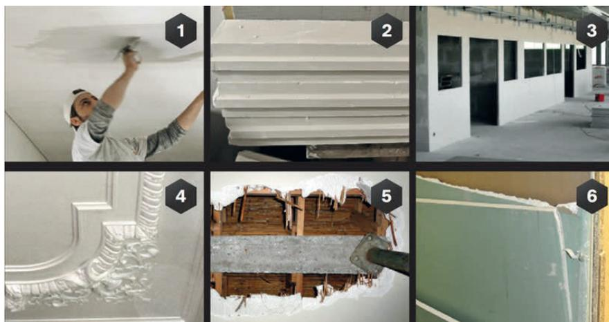
**Photo 1 – Plâtre pour enduit et à bâtir**
